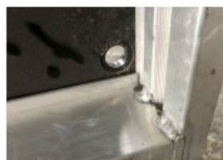
Passage de tige avec bague CP 15 mm PVC
