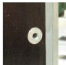
Rivets coniques têtes fraisées
