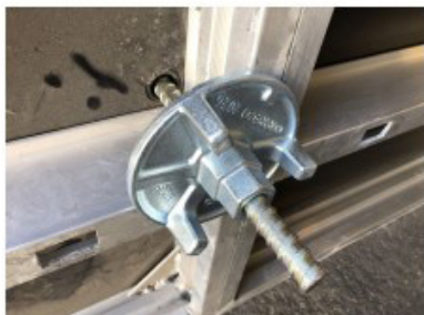
Assemblage tige écrou
