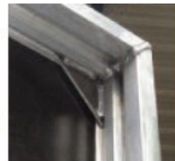
Renforts des angles par goussets 80x80 ép. 5 mm
